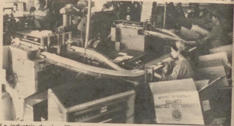
La industria de cigarrillos ha alcanzado un alto grado de mecanización. Puede observarse en la fotografía cómo las cajetillas discurren por unos toboganes mecánicamente, sin más intervención del personal que la práctica de una rigurosa inspección y control de producto.
